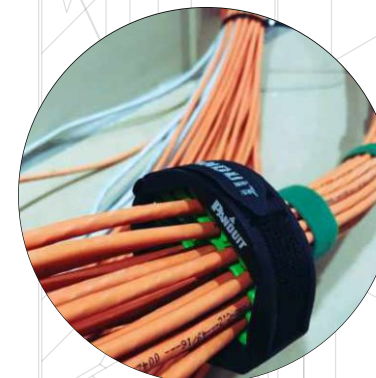
Сборка и монтаж кабелей и жгутов, монтаж радиоэлектронной аппаратуры
